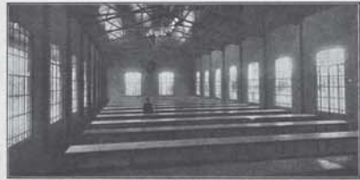
El salón comedor, con capacidad para mil personas.
