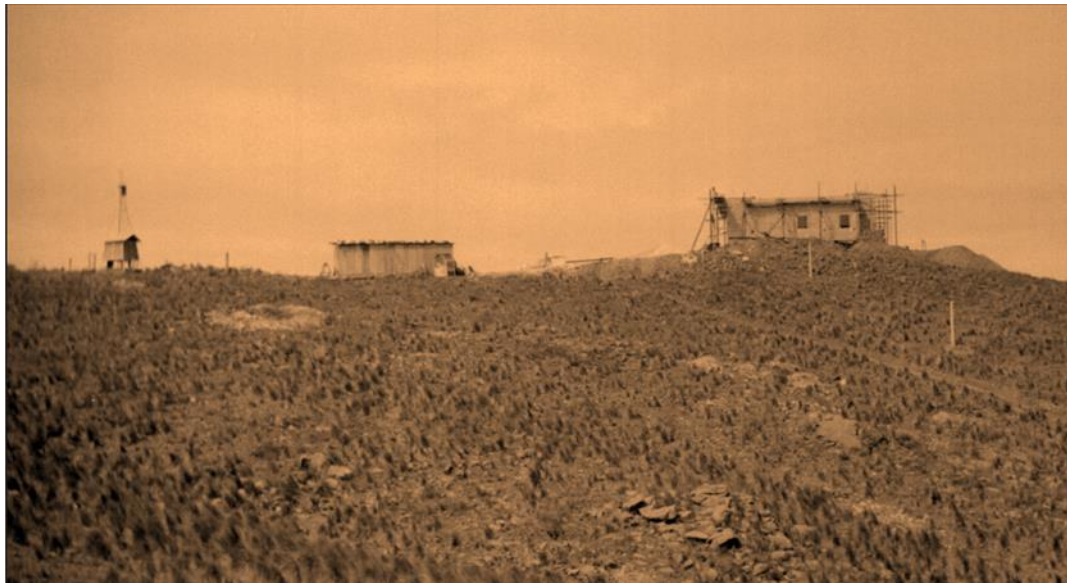
El pabellón en construcción – OAC – SP.-
